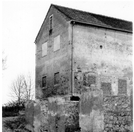
Durch teilweisen Abriss und Umbau entstand aus einer alten Turnhalle und Kegelbahn unsere Kreuzkirche. Der Glockenturm fehlt noch gänzlich.
